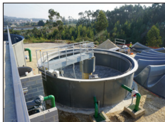
Décanteur W-Tank® et connexions.
