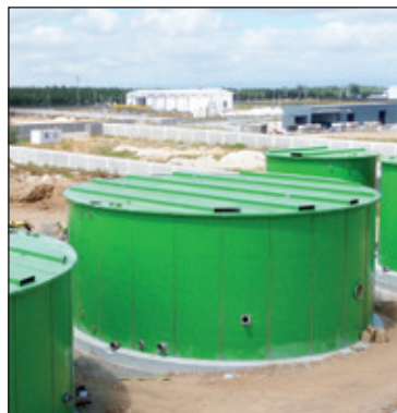
Couvertures plats W-Tank® hermétiques pour digesteurs.
