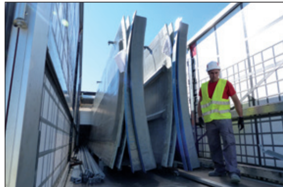
W-Tank® de H=11m, D=13.2m et 1,505 m 3 de capacité transporté en camion.
