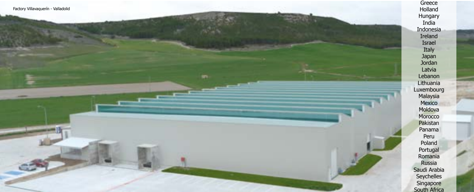
Factory La Cistèrniga - Valladolid
