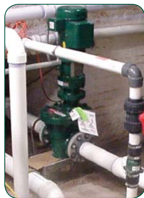
Mini Monster installé en ligne
