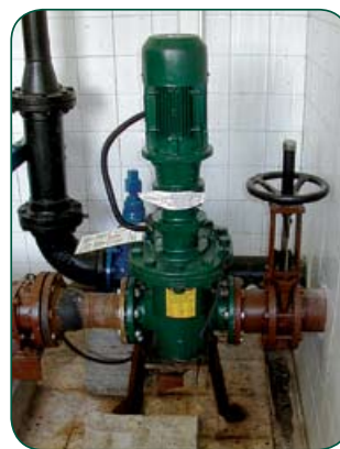
Mini Monster installé en ligne
