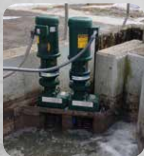
Modèle 30005 Installation en canal ouvert Muffin Monster®
