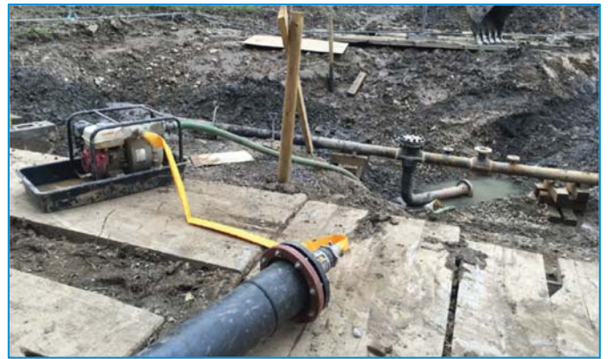
Réacteur tubulaire connecté à la pompe et à l'excavation
